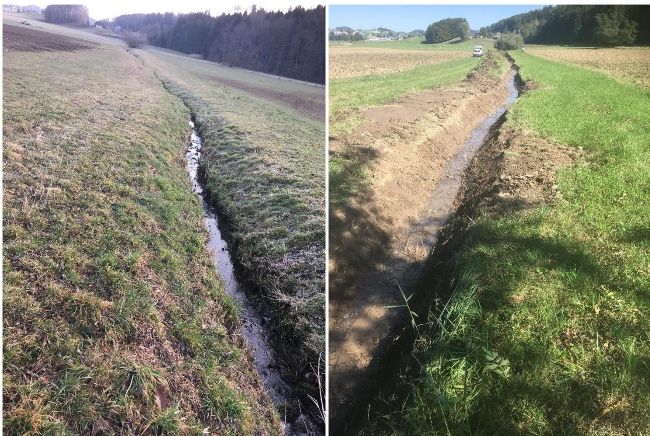
Ruisseau de la Mortigue avant et après les travaux de curage
