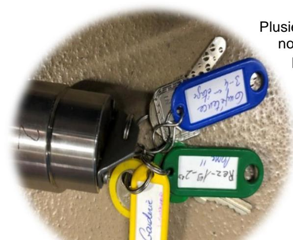
*Intérieur d'un tube à clé pour accès sapeur-pompier*
