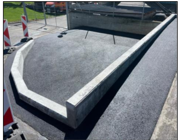
Image nouvelle place de stockage
