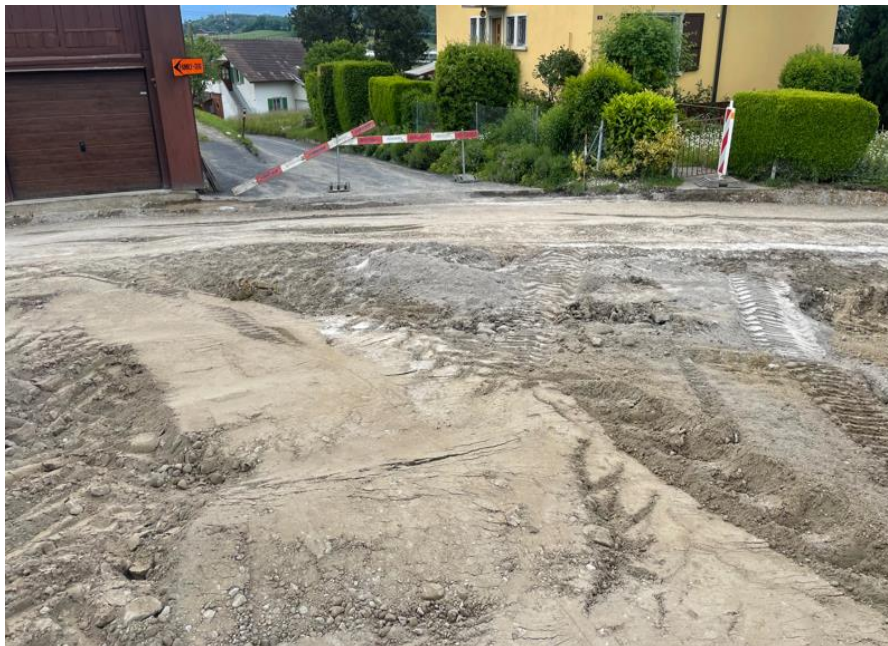
Travaux AF au chemin de la Grange Neuve
